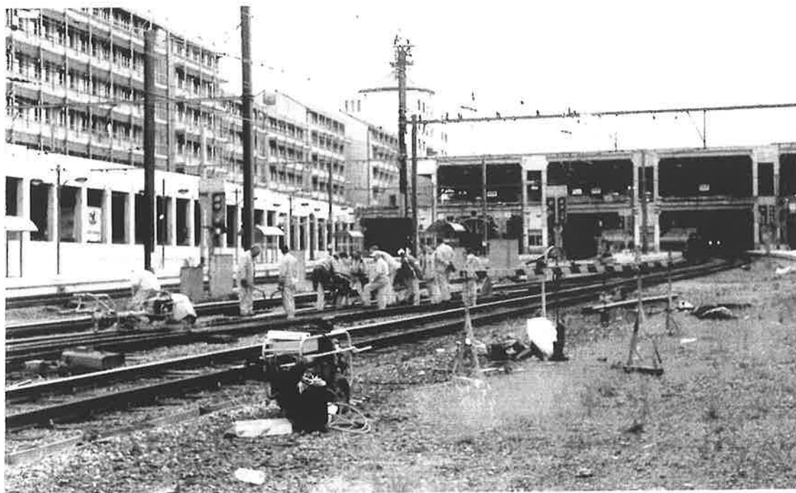
Les travaux d'aménagement du gril d'entrée de la gare de Namur, côté Bruxelles, se poursuivent activement. Namur, le 11 juin 2002 - Photo Guy Bridoux
